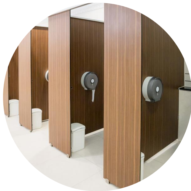
Toilettes et vestiaires
